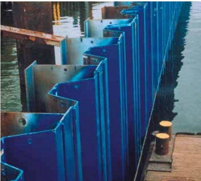
Dans la plupart des ouvrages maritimes en palplanches, la contrainte est maximale dans la zone immergée de manière permanente. La perte d'épaisseur dans cette zone est considérablement plus faible que dans les zones où la corrosion est la plus forte. À l'inverse, la contrainte dans l'acier est généralement très faible dans les zones de corrosion maximale :
