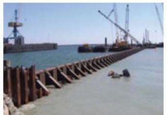
HZM/AZ, die mit Schrägpfählen verankert wurde. Dafür lieferte ArcelorMittal Commercial RPS insgesamt 3.500 Tonnen HZ 1080 M-24 mit einer Länge von 32 Metern, ferner 502 Tonnen AZ 13-10/10 in der Länge 19,20 Meter mit Beschichtung sowie 805 Tonnen HTM 400x117.
