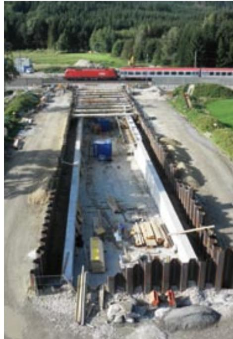
meter. Die Spundwände selbst werden mit Stahlrohrstützen gegeneinander abgestützt. Die Baugrube beim Bauabschnitt 1 hat einen Umfang von ca. 90 Metern, eingesetzt wurden hierfür Spundwandprofile PU 32 mit einer Länge von 18 m. Die Baugrubenumschließung bei den Bauabschnitten 2 und 3 beträgt jeweils ca. 220 Meter, dort kommen Spundwände mit einer Länge von 21,5 Metern zum Einsatz. Dabei wurden die Spundwände nach
