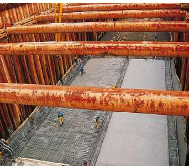
Par ailleurs, du fait de l'existence d'une couche de sable entre le fond de la tranchée et le pied des palplanches, un béton immergé a dû être coulé de manière à rendre l'excavation étanche. A mesure que la structure en béton du tunnel était réalisée, les palplanches pouvaient être retirées.
