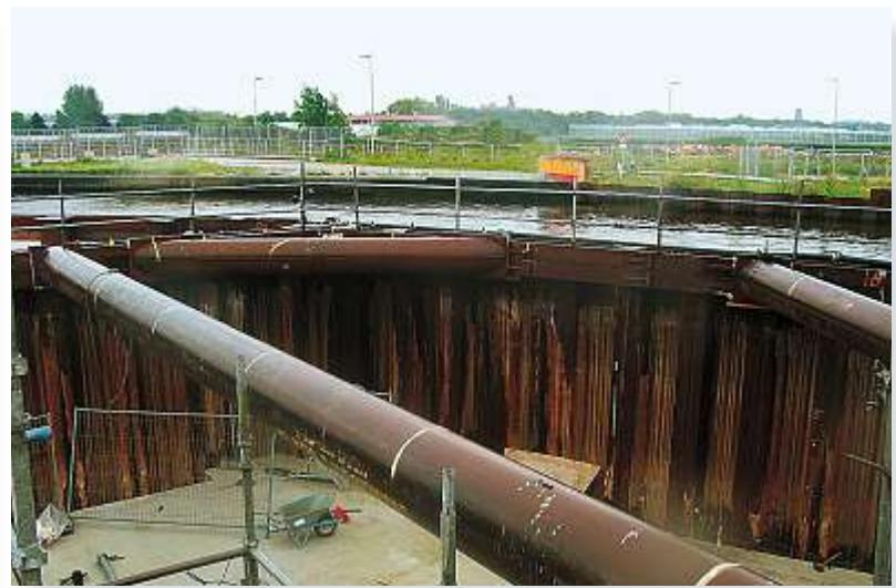
Le fonçage et l'extraction des palplanches ont été réalisés avec un vibrateur à fréquence variable. Le matériel utilisé a permis d'atteindre des cadences de 15 palplanches par jour pour le fonçage et de 25 palplanches par jour pour l'extraction.
