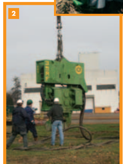
Vibreur équipé du capteur de retenue.
