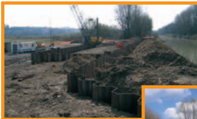
Le mur du quai et l'enceinte de la plate-forme sont entièrement réalisés en palplanches PU22 et PU8 représentant au total 215 tonnes
