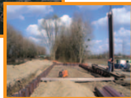
Le mur du quai et l'enceinte de la plate-forme sont entièrement réalisés en palplanches PU22 et PU8 représentant au total 215 tonnes
