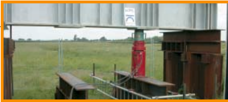
Dispositifs de mise en charge et de mesures.
