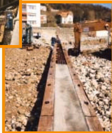
Couronnement béton plus poutre azobé en tête.
